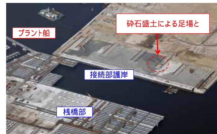
写真 - 3 SGM打設状況(1)
